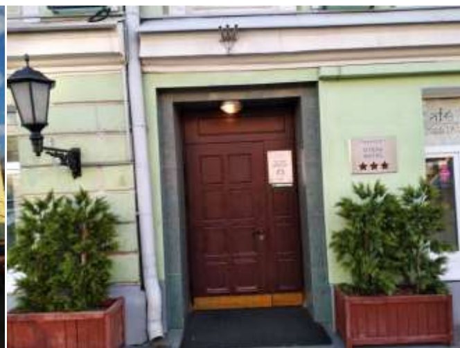
Фотография 3.2. Внешний вид здания
