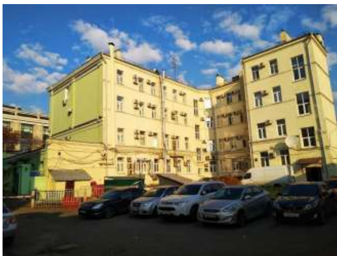
Фотография 3.1. Внешний вид здания
