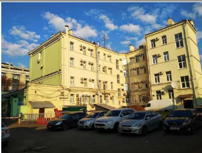
Фотография 3.1. Внешний вид здания
