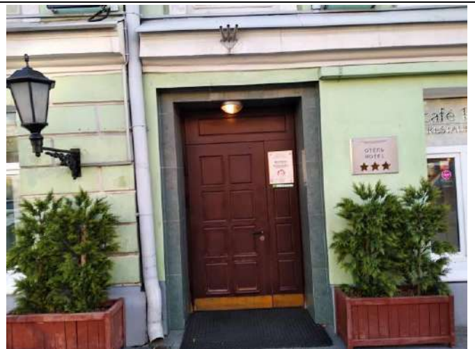
Фотография 3.2. Внешний вид здания
