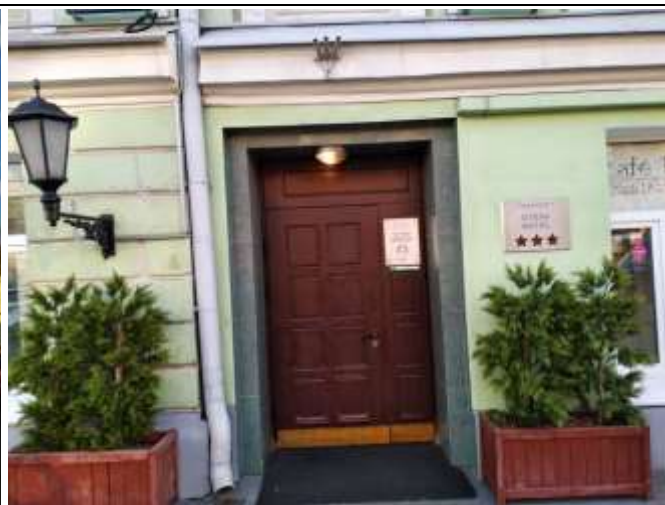
Фотография 3.2. Внешний вид здания
