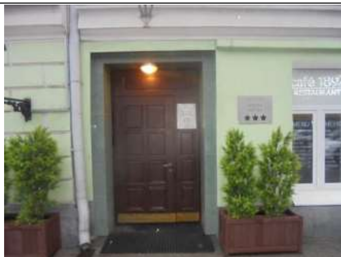
Фотография 3.8. Вход в оцениваемое здание
