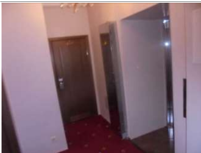
Фотография 3.33. Внутренние помещения здания стр. 1 (4 этаж)
