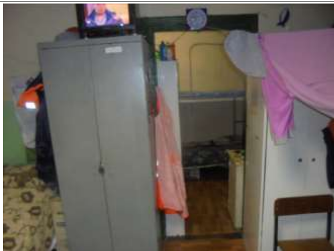
Фотография 3.46. Внутренние помещения здания стр. 2 (Подвал)
