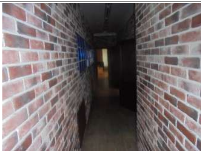
Фотография 3.54. Внутренние помещения здания стр. 2 (2 этаж)
