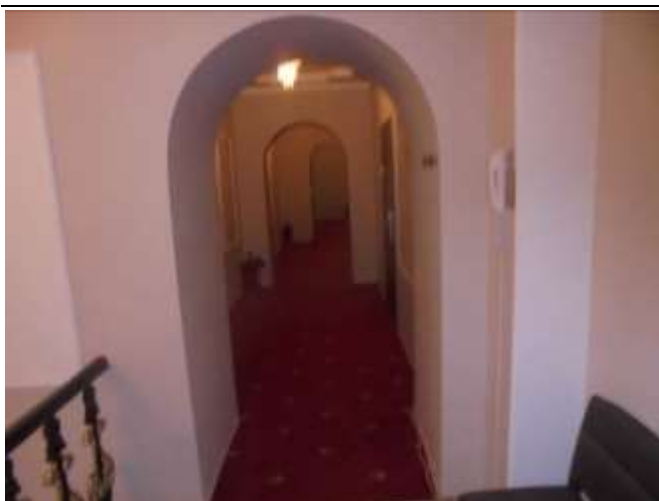
Фотография 3.31. Внутренние помещения здания стр. 1 (4 этаж)
