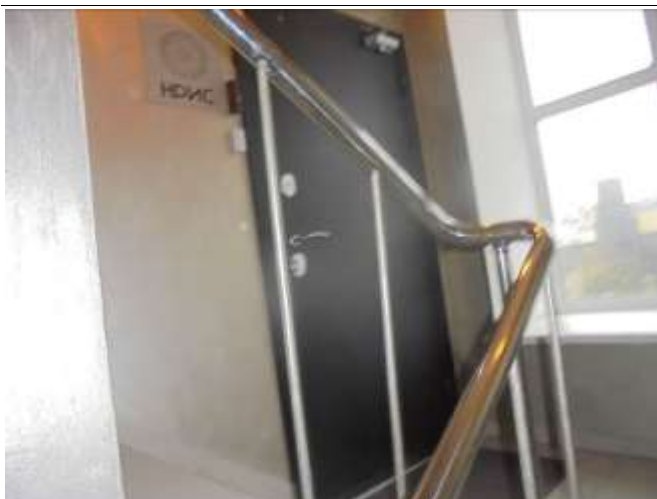
Фотография 3.63. Внутренние помещения здания стр. 2 (4 этаж)
