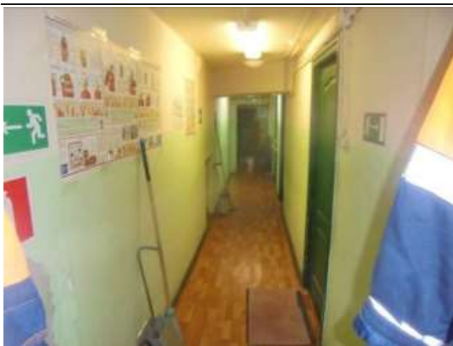
Фотография 3.43. Внутренние помещения здания стр. 2 (Подвал)
