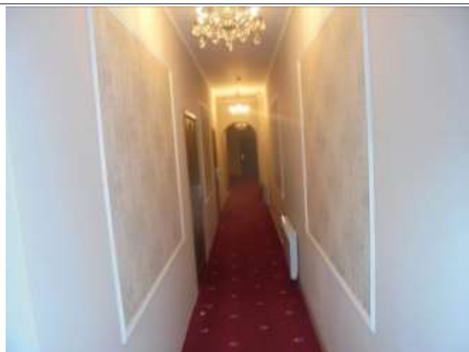
Фотография 3.22. Внутренние помещения здания стр. 1 (2 этаж)
